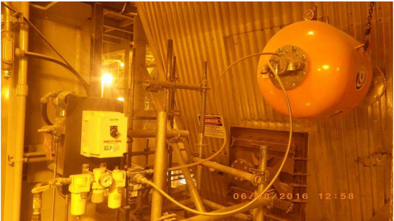
Photo 13 - Air Cannon In Hopper Under 2<sup>nd</sup>/3<sup>rd</sup> Pass
